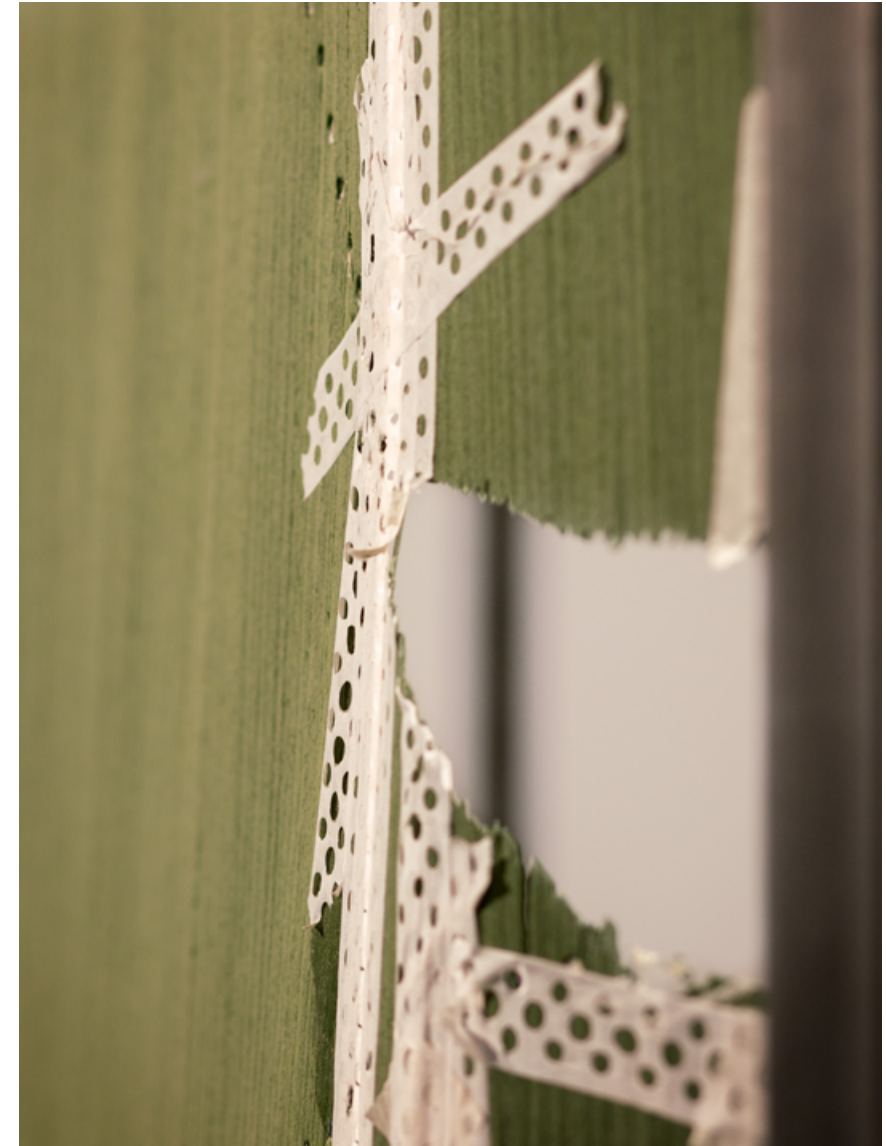
Detalles de la obra.
